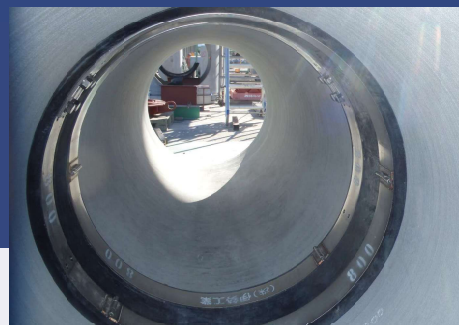
内面バンド取付後の管内
