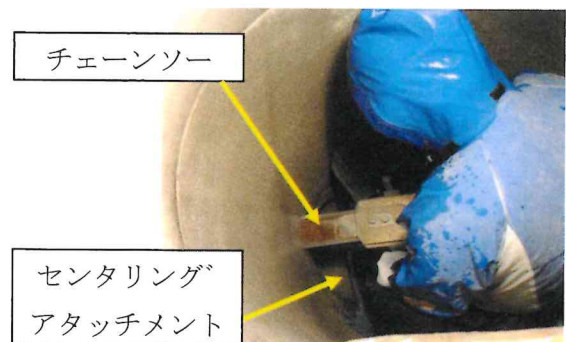
写真-2 切断削孔機による切削状況
