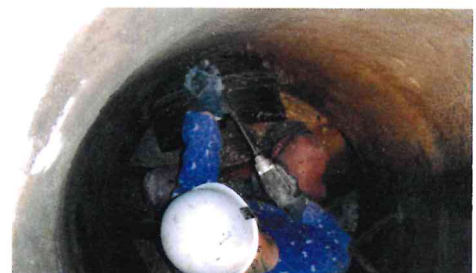
写真-3 耐震継手設置状況
