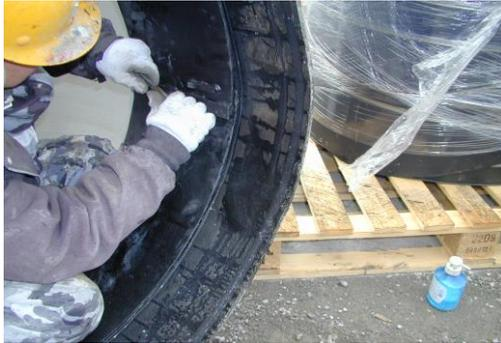
8. 鋼製スリーブにチューブゴム仮設置
